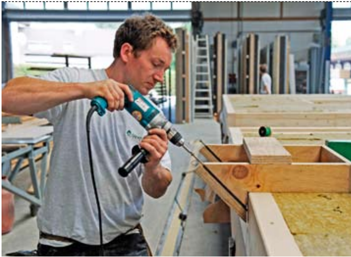
Die tragenden Fassadenelemente entstanden in der Vorfertigung und basieren auf einer Holzmassivriegelwand aus eigener Entwicklung, ausgesteift mit Furnierschichtholz-Schwellen und -Rahmen mit beidseitig angebrachten Gipsfaserplatten
