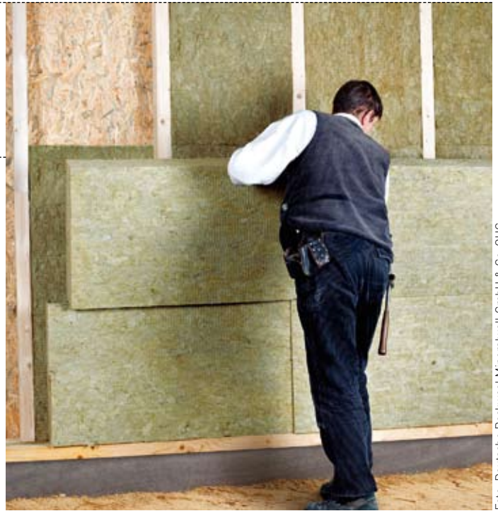
Bewährtes System: Mit dem Außenwand-Dämmsystem Meisterwand sorgen Zimmerer und Holzbauer für ausgezeichneten Wärme-, Brand- und Schallschutz im Holzbau. Indem sie die nichtbrennbaren Steinwolle-Dämmplatten an den Holzrahmen- bzw. Holzmassivwände befestigen, schaffen sie eine ideale Dämmung für die hinterlüftete Fassade
