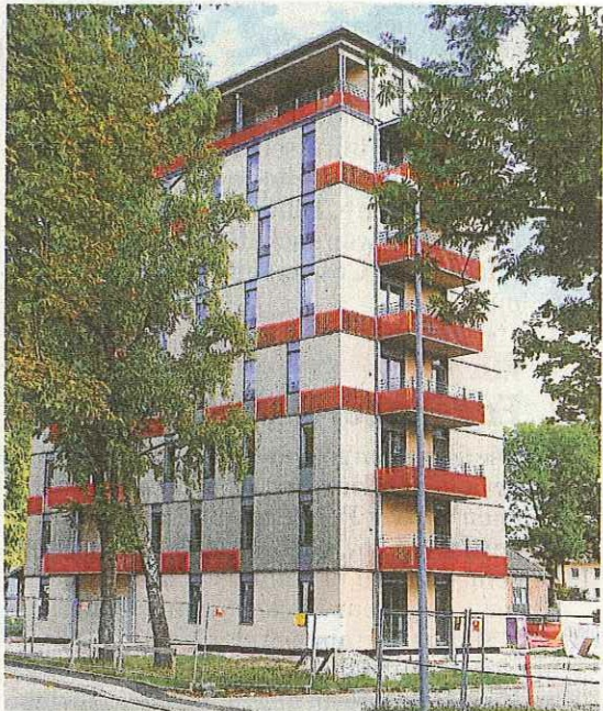
Es ist absolut umweltfreundlich gebaut und zeigt, wohin der Trend geht: das achtstöckige Rekord-Holzhaus in Bad Aibling
