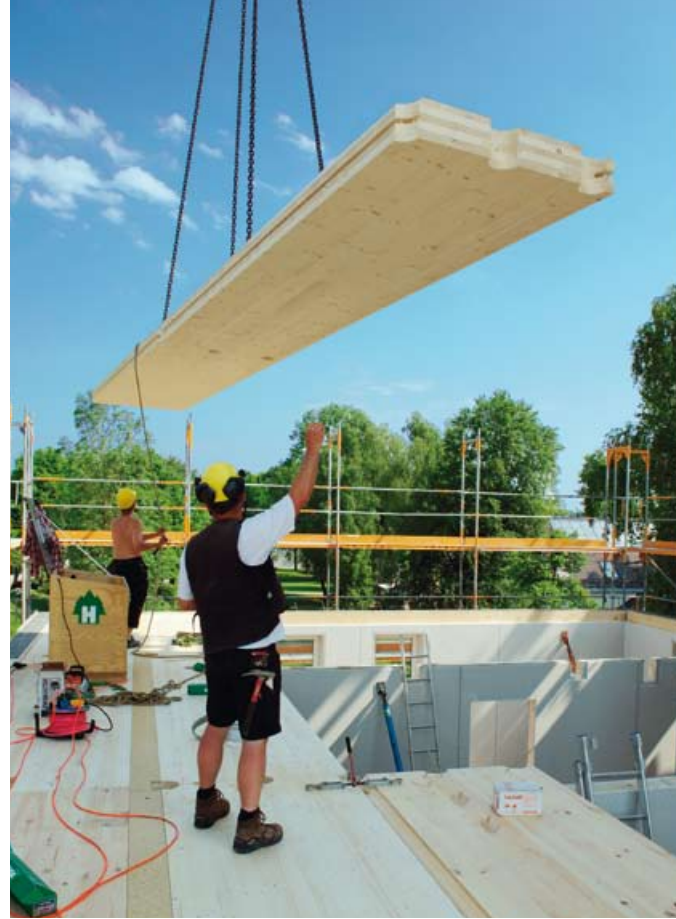
◀ Huber & Sohn fertigte die großformatigen Brettsperrholzelemente inklusive Fenster, Holzschalung und Putzträgerplatten
