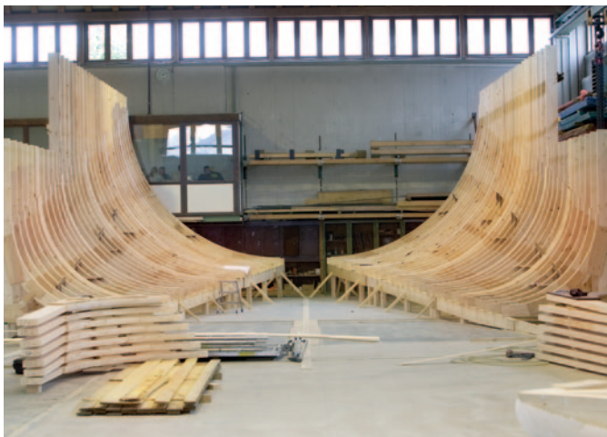
Die Holzkonstruktion der Außenschalung bei der Vorproduktion im Werk. Die Geometrie ändert sich von rund auf eckig.
