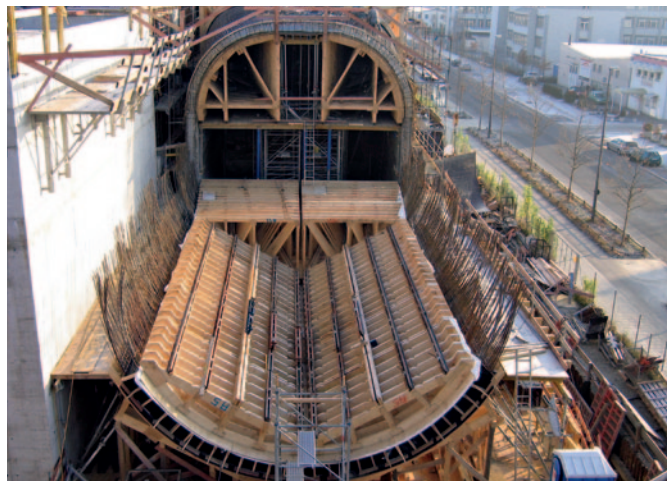
Abschnittsweise wurden Boden, Wand und Decke eingeschalt und betoniert.
