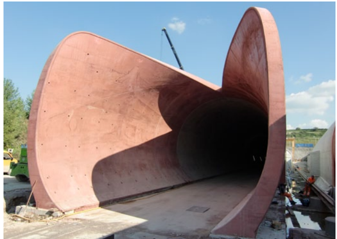
Das Portalbauwerk Gleis 9 nach dem Ausschalen.
