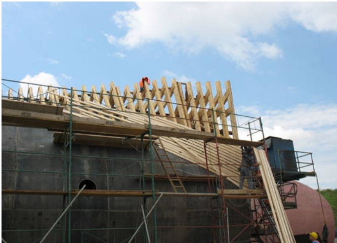
Aufbringen der Schalung für den doppelt gekrümmten Bereich des Portalbauwerkes Gleis 9.
