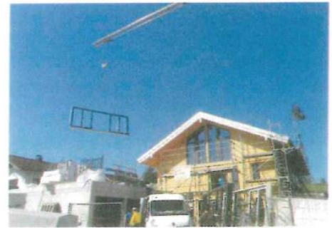
Montage einer großflächigen Holz/Alu-Fenster-Hebeschiebetüre mit Doppel-Schiebeflügel und Festverglasung in einem modernen Wohnhaus.
