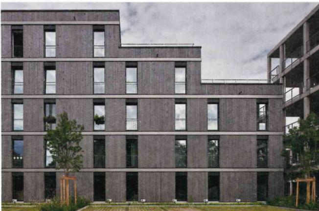
Bild 3 Holztafelaußenwände, geschosshoch vorgefertigt
