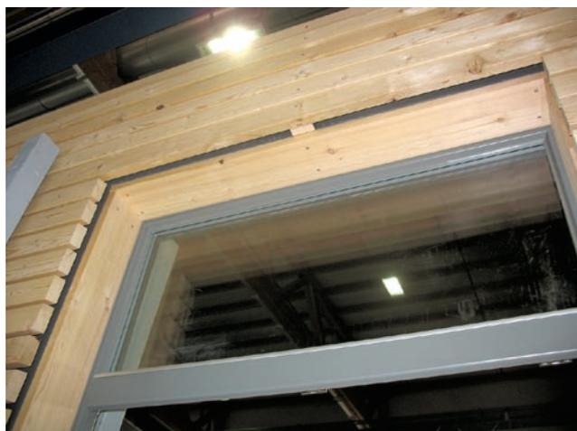
**Bild 6 Auch im Detail Qualität, die Baustellenarbeit mit Einmessen nicht bieten kann: Die Passgenauigkeit der Sägeschnitte ist „Schreinerarbeit“ und auch die Schrauben sitzen planmäßig, nicht nach Augenmaß gesetzt, zudem stören keine „Bleistift-Strichreste“ von Anrissen auf dem Holz.**
