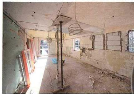
Die Erkenntnis, dass die letzte Geschosdecke keine Lasten aufnehmen kann, führte zu der Lösung, diese Decke komplett durch eine neue Tragkonstruktion zu überbrücken.
