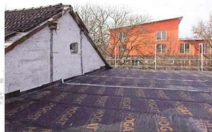
Die gewählte Brettsperrholzdecke, mit Auflagerpunkten an den Außenwänden und den Mittelwänden kragt über die Außenwände um 0,45 m umlaufend aus, einerseits zum Ausgleich eventueller Maßtoleranzen bei den bis zu 80 m langen Blöcken, andererseits um den Detailpunkt „Übergang des Wärmedämmverbundsystems des Bestandes zur Aufstockung“ fehlertolerant zu gestalten.
