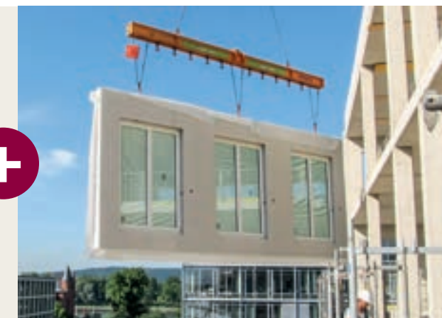
Montage der vorproduzierten Wandelemente, mit eingebauten Fenstern
