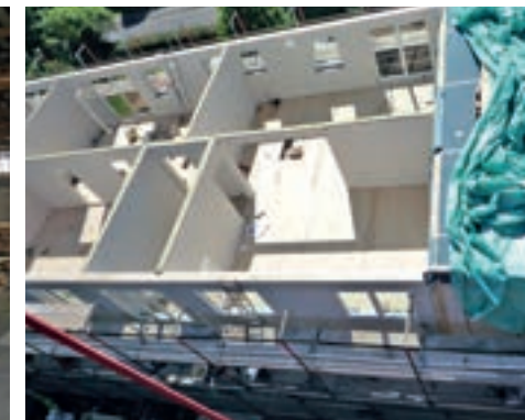
Montage der Wände...
