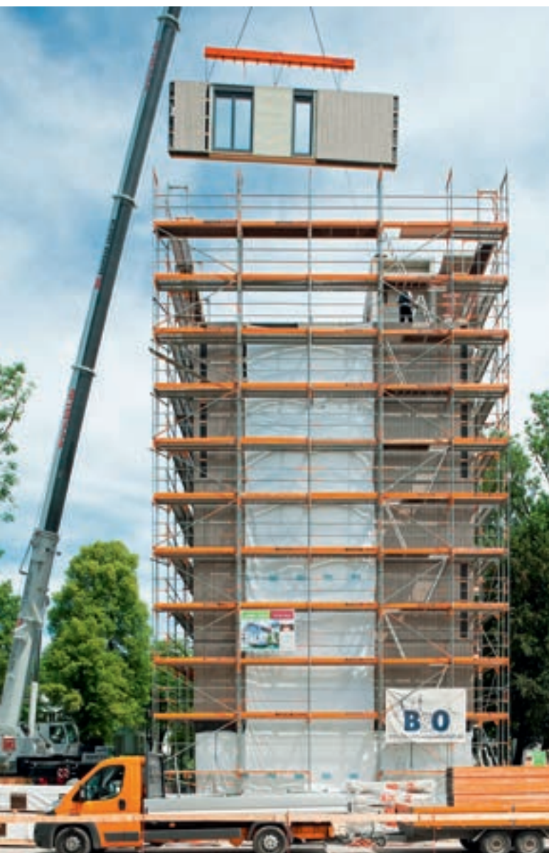
Montage der vorgefertigten Wandelemente
