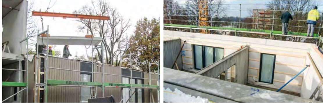
Holz und Beton übernehmen bei dieser Bauweise gemeinsam die statischen Lasten. Statisch tragende Holzaußenwände und Betoninnenwände tragen gemeinsam die Betondecken. So kann man die Vorteile von Holz und Beton gleichermaßen nutzen. Beton ist sehr preiswert und statisch hoch belastbar, Holz hat die deutlich besseren Wärmedämmeigenschaften und ist ebenfalls sehr belastbar.
