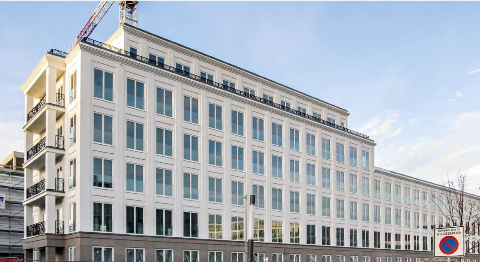
Eine Variante der Holz-Beton-Hybridbauweise kann man kurz so beschreiben: Beton trägt – Holz schützt. Es wird eine Tragstruktur aus Stützen und Decken in Ortbetonbauweise errichtet. Wenn diese Arbeiten abgeschlossen sind, werden die vorgefertigten Fassaden aus Holzwandelementen montiert. Die statischen Lasten trägt die Betonstruktur, die Holzwände übernehmen den Witterungsschutz, den Wärmeschutz und den Schallschutz gegen Außenlärm.
