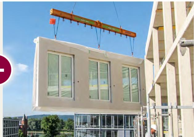
Montage der vorproduzierten Wandelemente, mit eingebauten Fenstern
