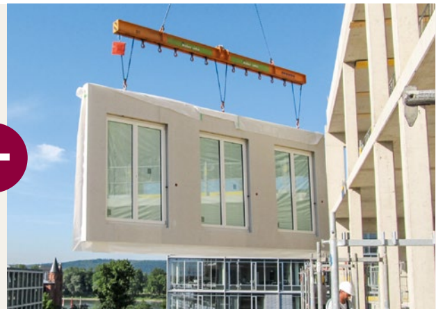
Montage der vorproduzierten Wandelemente, mit eingebauten Fenstern
