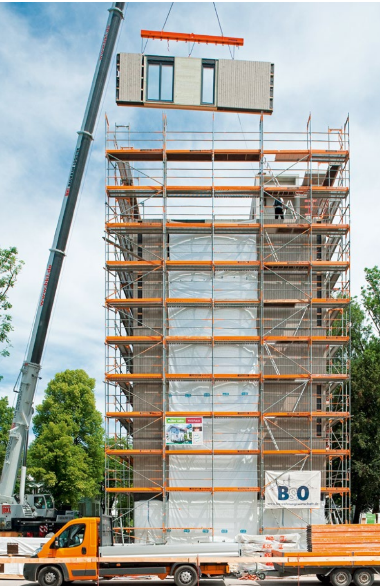
Montage der vorgefertigten Wandelemente
